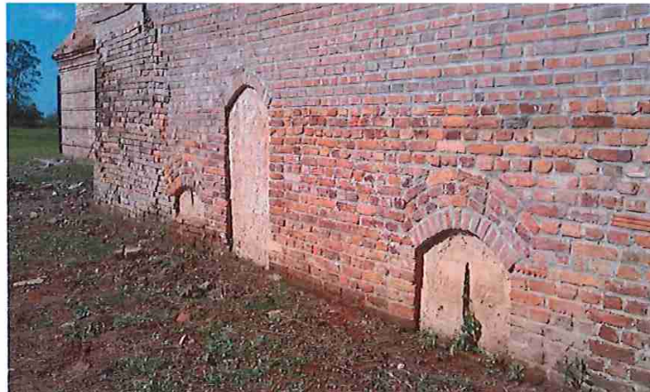
8. El cambio de tonalidad de la fábrica muestra cómo la cota anterior a la actuación alcanzaba niveles de entre 30 y 80 cm sobre la rasante actual.
