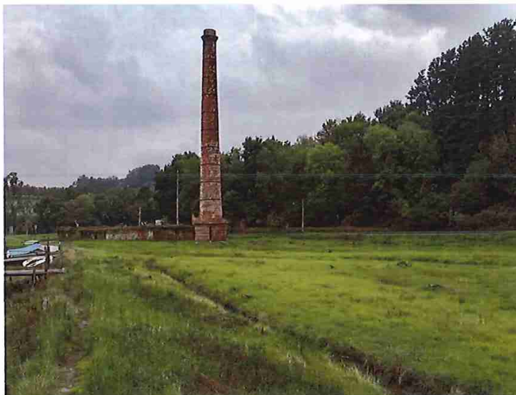
4. Vista general desde el Norte. Antes del inicio de las actuaciones de puesta en valor del patrimonio industrial, la cota de la parcela donde se ubica la chimenea es la misma que la situada al Norte.
