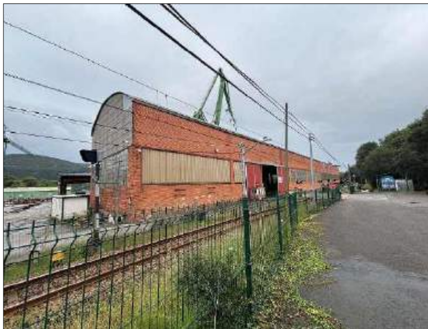
Foto 3. Nave de prefabricación junto a las vías del tren.
