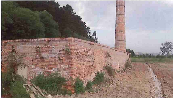
5. El muro Este del horno Hoffman. Obsérvese la altura del terreno en contacto con la fábrica.
