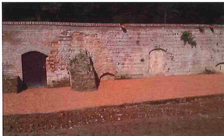
9. Fábrica despejada y entomo pavimentado con árido de ladrillo machacado.
