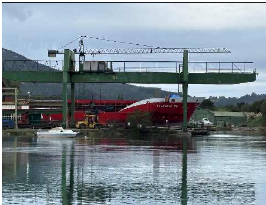
Foto 4. Grúa puente en el parque de chapas.
