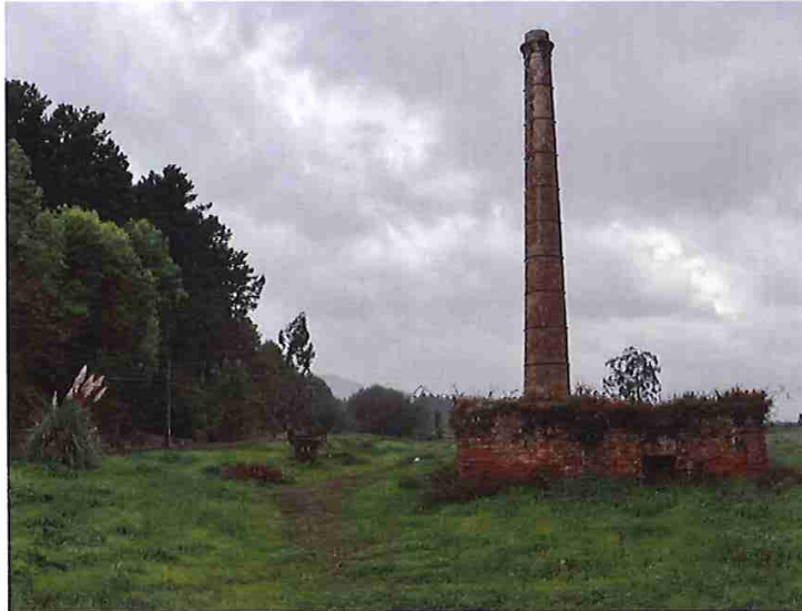
1. Vista del conjunto homo Hoffman y chimenea, antes del inicio de las actuaciones.
