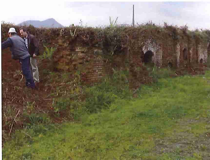
3. Vista desde el extremo Noroeste, al inicio del desbroce.
