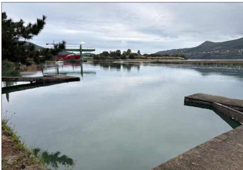
Foto 8. Vista del astillero en momento de máxima altura del agua.
