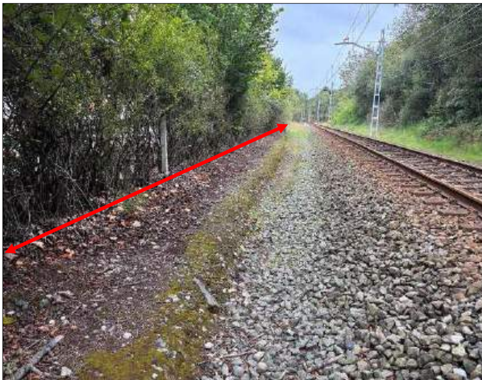
Foto 12. Línea de ribera del mar calculada en el borde de explanación del ferrocarril.
