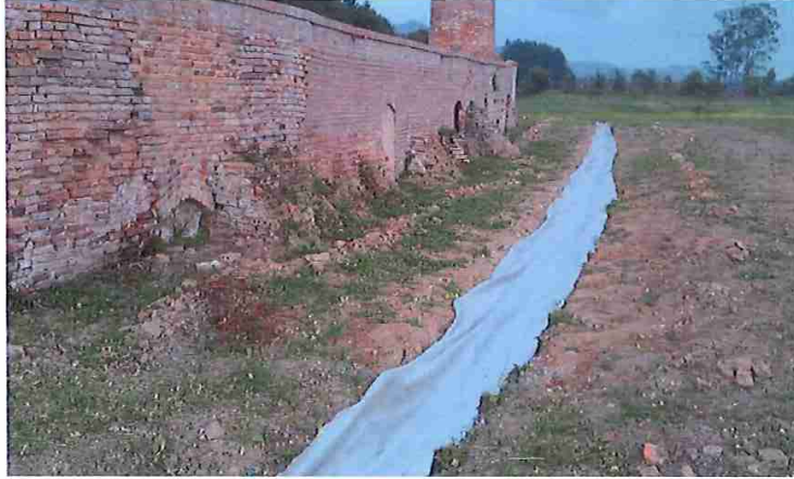
7. Ejecución del drenaje. El rebaje de la cota tiene por objeto la puesta en valor y la protección del arranque de las fábricas.
