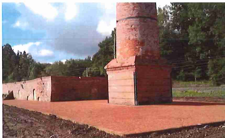
10. Vista desde el Nordeste de la obra terminada. El nivel original se puede apreciar a la derecha de la imagen.
