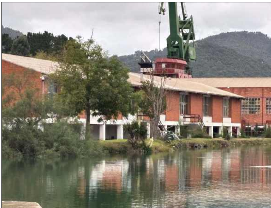
Foto 5. Pabellón de comedor y vestuarios y grúa entre los diques.
