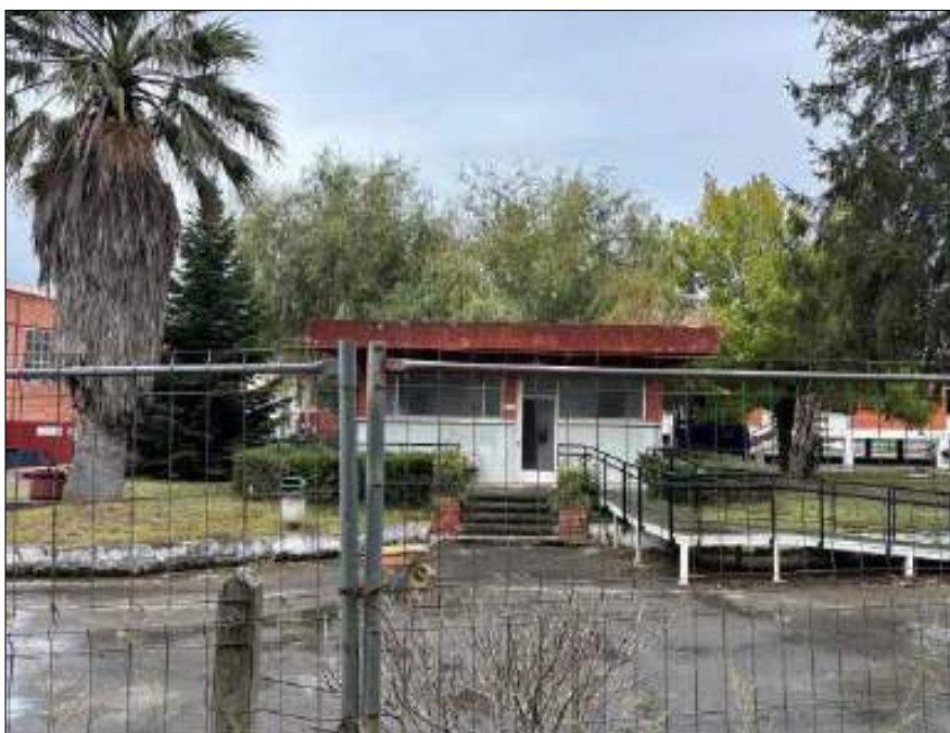
Foto 6. Edificio de enfermería.
